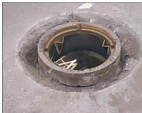
Der Schachtvergussmörtel kann mit dieser Vorrichtung vollflächig unter den Schachtrahmen vergossen werden. Eine sichere Abdichtung wird durch das elastische Moos-Gummi erreicht und die spezielle Verschraubung ermöglicht den gleichmäßigen Anpressdruck an die Schachtwand.
