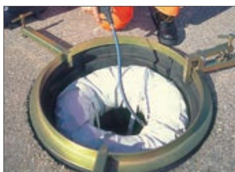
Für Schachtrahmen-Ø 600 - 620 mm mit integriertem Dichtstreifen und Einfüllrohr.
