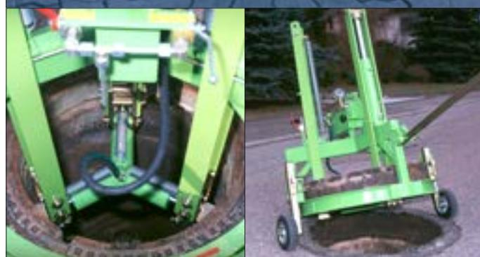
Die perfekte Maschine zur Schachtrahmensanierung für den Einsatz im Kommunalbereich.
