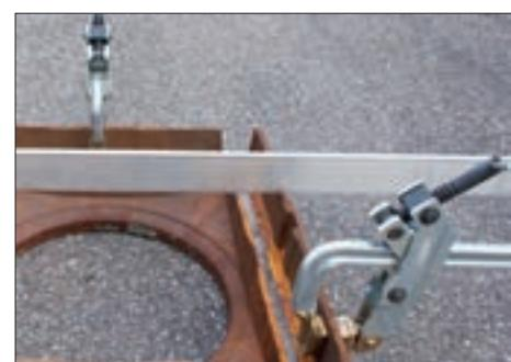
Dieses Gerät eignet sich speziell zur Höhenjustierung von Schachtabdeckungen aller gängigen Straßenabläufe. Mit dem Nivellierlineal und den 3 am Ende der Justiereinheiten angebrachten Stellschrauben kann das Höhenniveau exakt eingestellt werden.
