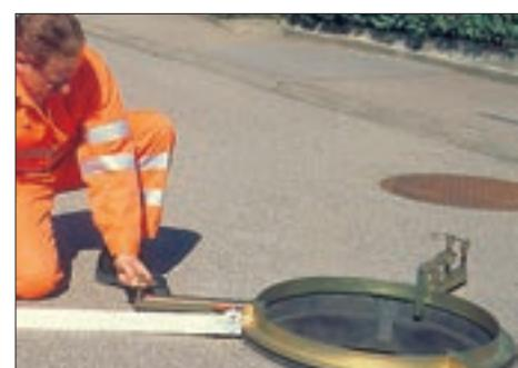
Die Vorrichtung zum exakten und einfachen Nivellieren von Schachtrahmen.
