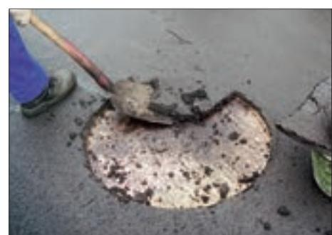
Zum Abdecken des Schachtdeckels beim Einbau von Verschleißdecken, unbeschichtet.
