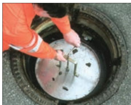
Mit wenigen Handgriffen lässt sich diese leichte und trotzdem äußerst stabile Absperrplatte im Schachtkonus von allen runden Abwasserkontroll- und Hydrantschächten mit ca. 600 mm-Ø einsetzen und durch zwei über der Platte angeordneten Spannpratzen sicher befestigen. Durch den nach oben um 300 mm verlängerten Haltebügel samt Spannachse und Kurbel lässt sie sich besonders leicht und bequem handhaben.
