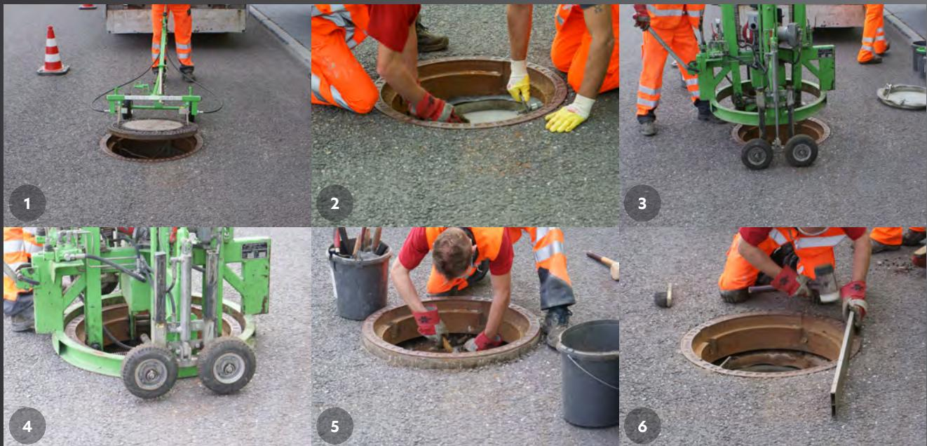
1. Ausheben des Schachtdeckels mittels Schachtdeckel-Hebewagens UDH-60 und Entfernen des Schmutzfängers.
