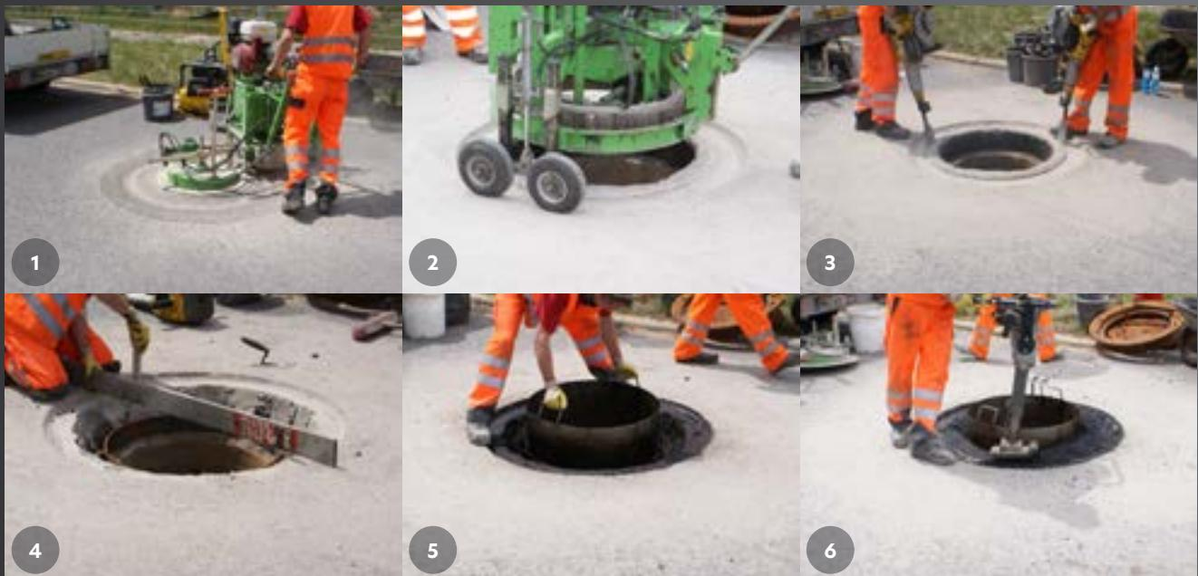
1. Kreisrundes Fräsen um die Schachtabdeckung mit einer unserer Spezialfräsen.
