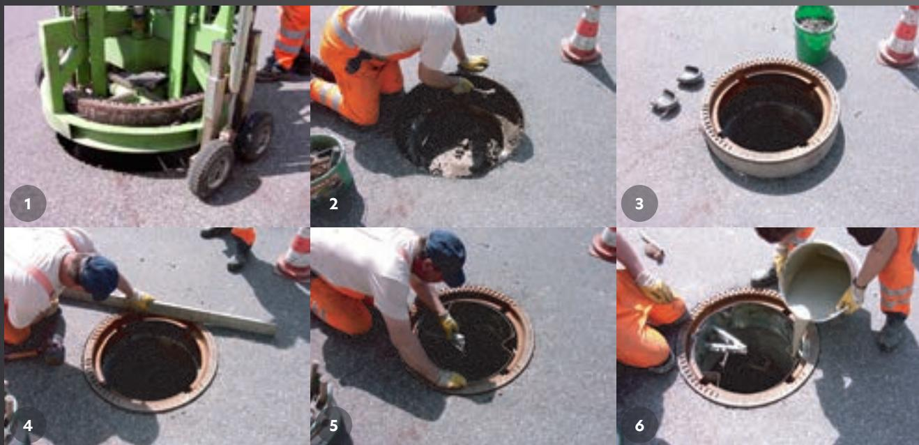
1. Einbringen der Schachtabsperrplatte und Ausbau der defekten Schachtabdeckung mit dem Schachtrahmenheber.
