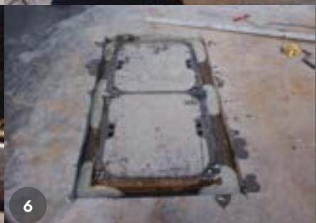
1. Schneiden des Asphaltes und Freilegen des Arbeitsraumes.
